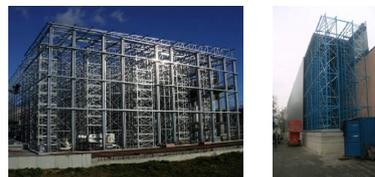
Das automatische Magazin ist im Stande auch bei großen Höhen Produkte aufzustocken. Dies geschieht komplett automatisch und die Ware ist jederzeit zugänglich.
